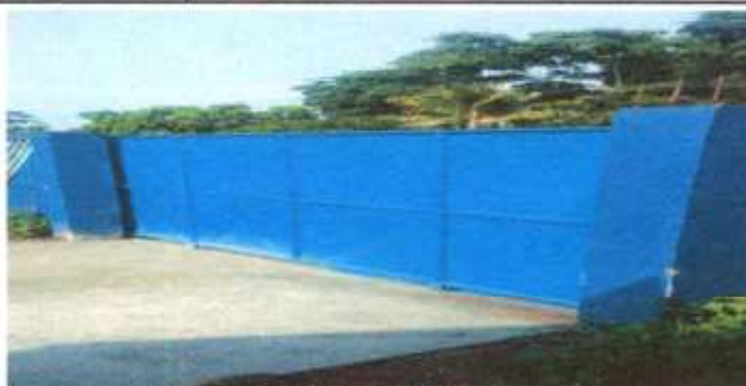
Foto 2: Suministro y sustitución de portón de metal
