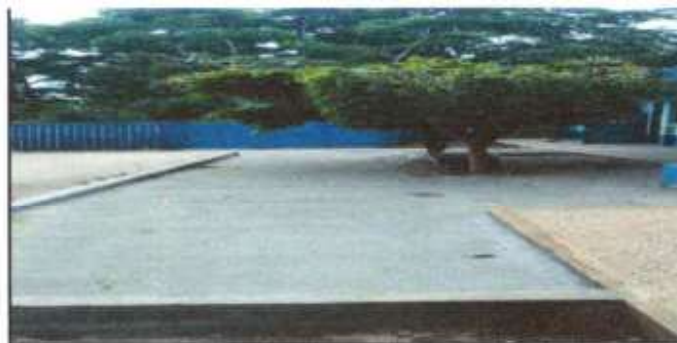
Foto 6: Suministro e instalación de torta de concreto de T=0.08 M en patio
