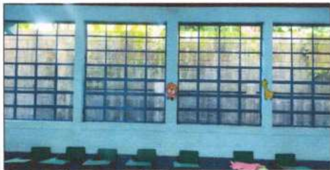
Foto 3: Suministro y mantenimiento de estructura de metal de ventanas
