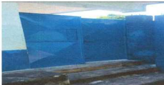
Foto 4: Suministro y sustitución de puerta de metal
