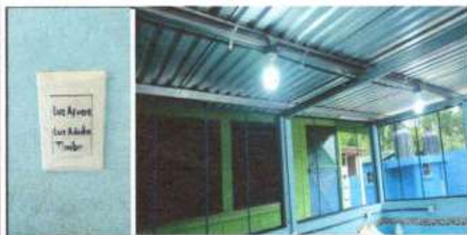
Foto 5: Suministro e instalación de interruptores dobles y cambio de plafoneras y lámparas
