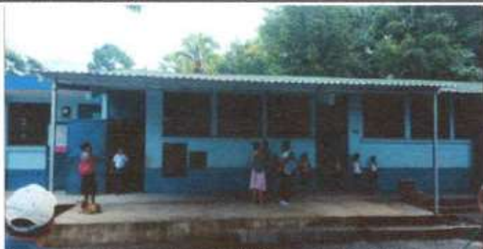
Foto 1: Suministro e instalación de láminatroquelada de Aluzinc cal. 26
