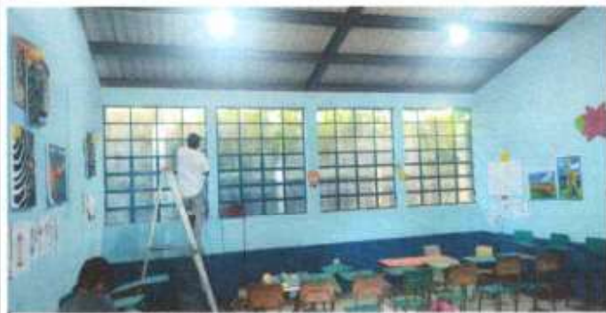
Foto 3: Suministro y mantenimiento de estructura de metal de ventana
