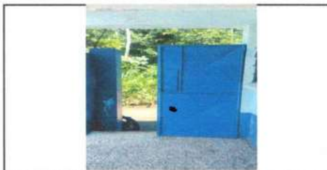
Foto 4: Suministro y sustitución de puerta de metal
