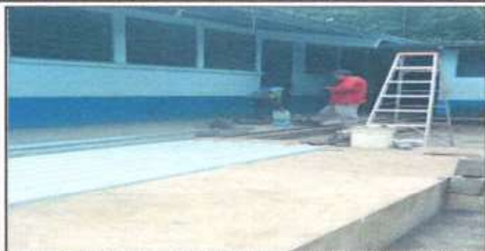
Foto 1: Suministro e instalación de láminas troqueladas de Aluzinc cal. 26
