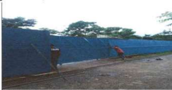
Foto 2: Suministro y sustitución de portón de metal
