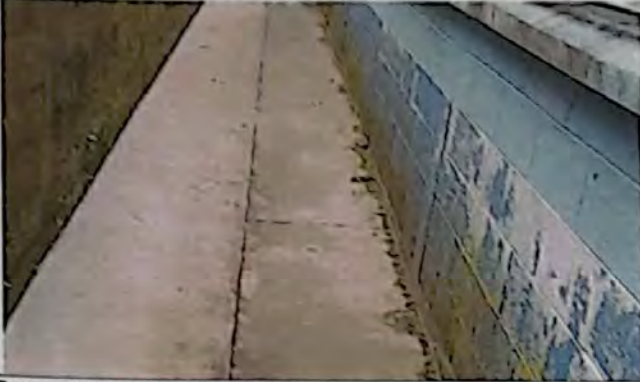
Banqueta de protección módulo 1
