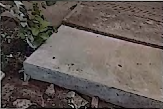
Fundición de encaminamiento área de cocina
