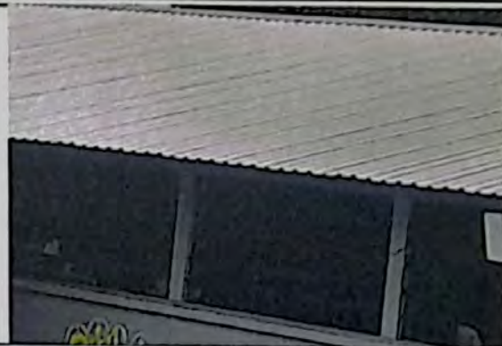
Sustitución de lámina en módulo de 1 aula
