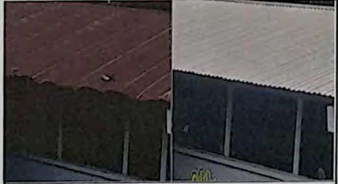
Sustitución de lámina en módulo de 1 aula
