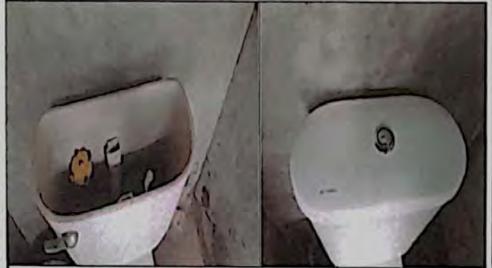
Cambio de inodoros y accesorios
