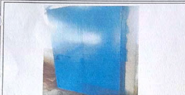
Foto 1: CAMBIO DE PUERTA
