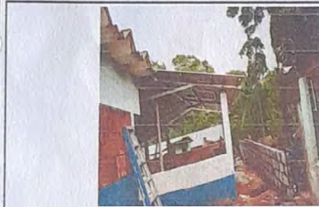
Foto 1: ESTRUCTURA Y CAMBIO DE LAMINA
