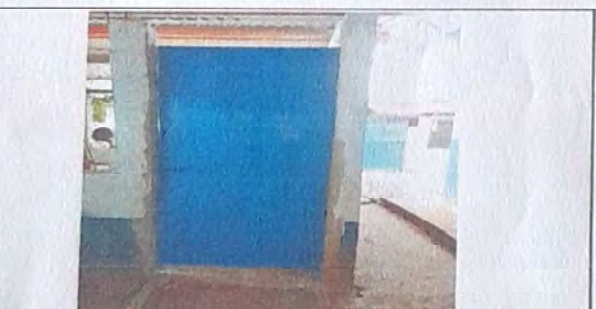
Foto 5: CAMBIO DE PUERTA
