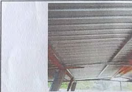
Foto 6: ESTRUCTURA Y CAMBIO DE LAMINA
