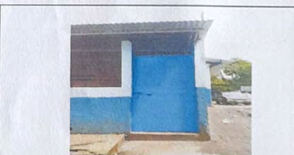
Foto 6: CAMBIO DE PUERTA
