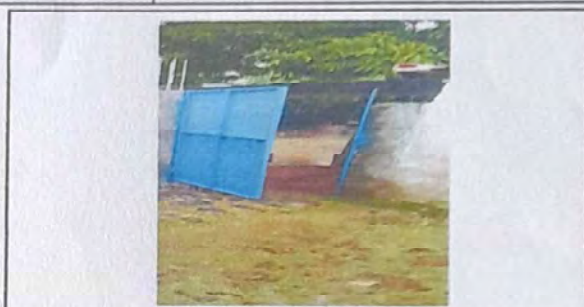
Foto 2: CAMBIO DE PUERTA
