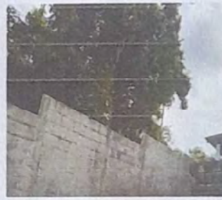
Foto 2: CONCLUSION MURO PERIMETRAL
