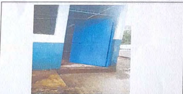
Foto 3: CAMBIO DE PUERTA
