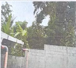
Foto 3: CONCLUSION MURO PERIMETRAL
