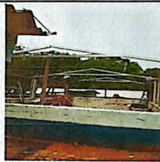
Foto 2: ESTRUCTURA Y CAMBIO DE LAMINA
