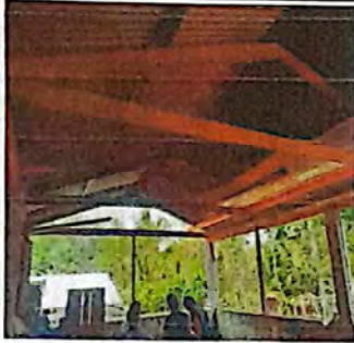
Foto 1: ESTRUCTURA Y CAMBIO DE LAMINA
