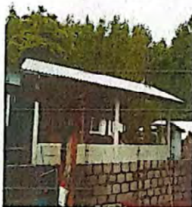
Foto 3: ESTRUCTURA Y CAMBIO DE LAMINA
