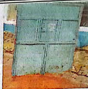
Foto 2: CAMBIO DE PUERTA
