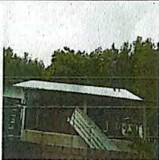
Foto 5: ESTRUCTURA Y CAMBIO DE LAMINA
