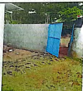
Foto 5: CAMBIO DE PUERTA
