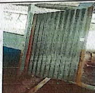
Foto 4: CAMBIO DE PUERTA
