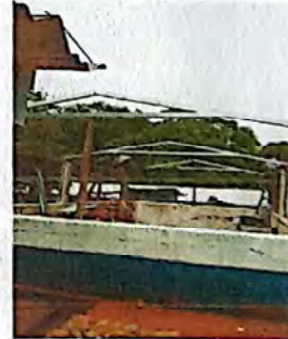
Foto 4: ESTRUCTURA Y CAMBIO DE LAMINA
