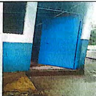
Foto 6: CAMBIO DE PUERTA
