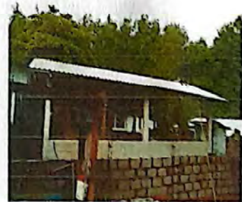
Foto 6: BLOCKS CON COLUMNAS
