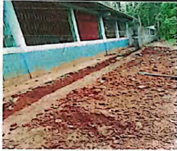
Foto 1: INICIO DE ZANJEADO
