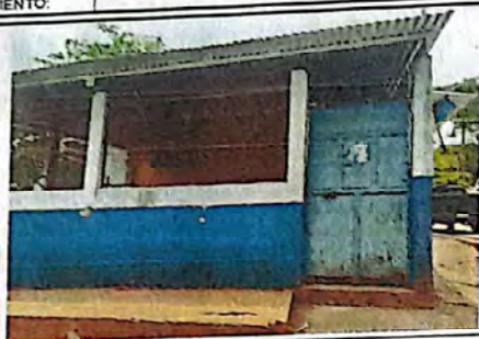
Foto 1: CAMBIO DE PUERTA
