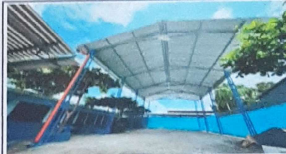
Foto 2: VISTA DE INSTALACIÓN DE LÁMINA FINALIZADO
