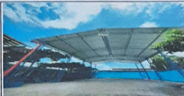
Foto 1: VISTA FACHADA INTERIOR LAMINA COLOCADA AL 100%
