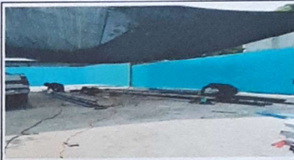
Foto 4: MANTENIMIENTO DE PINTURA DE LA ESTRUCTURA METALICA
