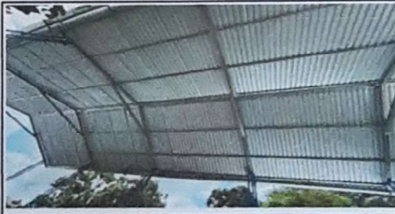
Foto 6: FINALIZA LA COLOCACIÓN DE LÁMINAS
