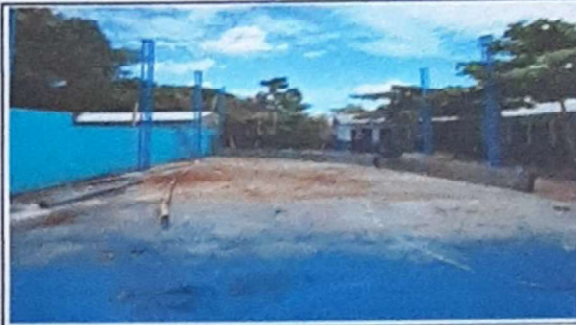
Foto 2: SUMINISTRO E INSTALACIÓN DE COLUMNAS PRIMERA FASE
