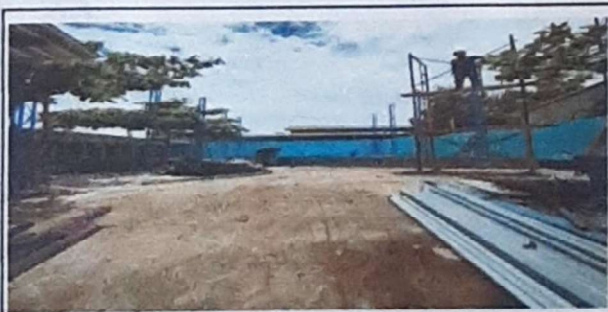
Foto 5: SUMINISTRO E INSTALACIÓN DE VIGAS METALICAS Y LÁMINAS
