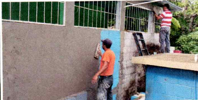
Foto 2: Puede verificarse la aplicación de repello en muros exteriores.
