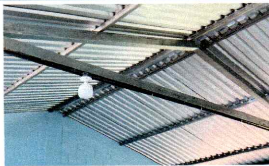
Foto 6: Se puede verificar la instalación de cubierta de lámina troquelada calibre 26 e instalación de lámparas tipo led.
