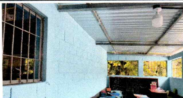
Foto 5: Se ha concluido con la instalación de cubierta de lámina troquelada calibre 26.
