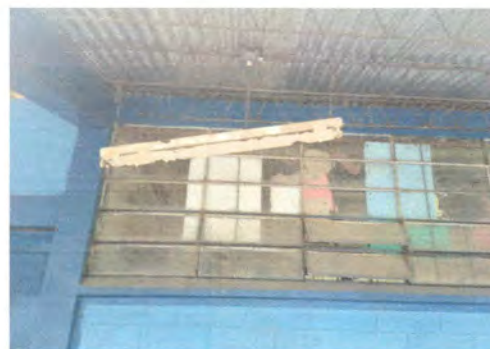
Foto 10: MEJORAMIENTO TRABAJOS DE ELECTRICIDAD MODULO 1
