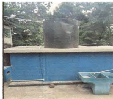
Foto 4: SUMINISTRO DE TANQUE DE AGUA
