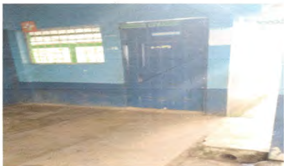
Foto 3: SUSTITUCION DE PUERTA
