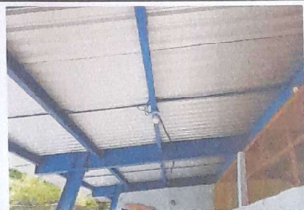
Foto 6: VISTA INTERIOR MANTENIMIENTO A ESTRUCTURA DE METAL Y SUSTITUCION DE LAMINA
