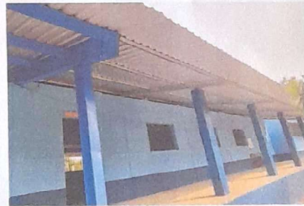
Foto 4: SUSTITUCION DE ESTRUCTURA DE METAL Y LAMINA
