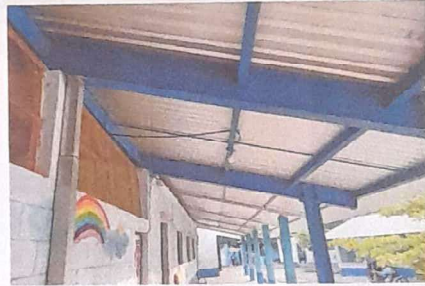
Foto 2: VISTA DE INSTALACIÓN DE LÁMINA FINALIZADO
