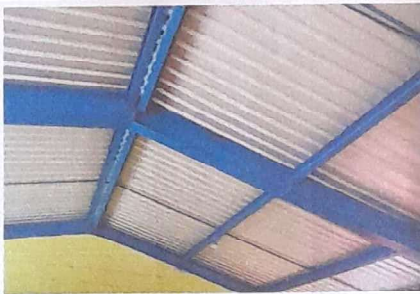
Foto 3: VISTA INTERIOR MANTENIMIENTO A ESTRUCTURA DE METAL Y SUSTITUCION DE LAMINA
