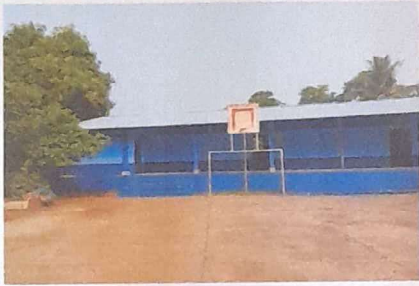
Foto1: VISTA FACHADA LAMINA COLOCADA AL 100%
