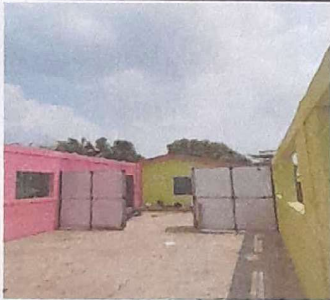
Foto 3: SUSTITUCION DE ESTRUCTURA DE METAL
