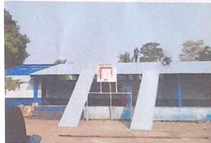
Foto 4: SUSTITUCION DE LAMINA TROQUELADA CALIBRE 26
