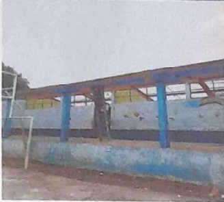
Foto 1: MANTENIMIENTO A ESTRUCTURA DE METAL
