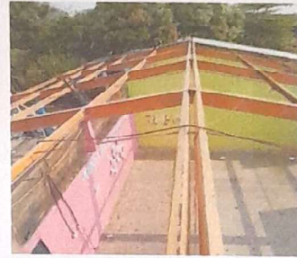
Foto 2: MANTENIMIENTO A ESTRUCTURA DE METAL
