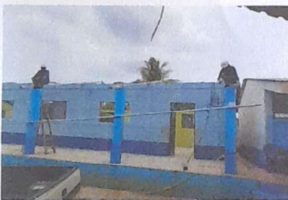
Foto 5: SUSTITUCION DE ESTRUCTURA DE METAL
