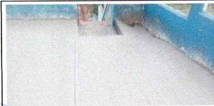
Foto 6: Se puede verificar el mejoramiento de piso de torta de concreto en patio.
