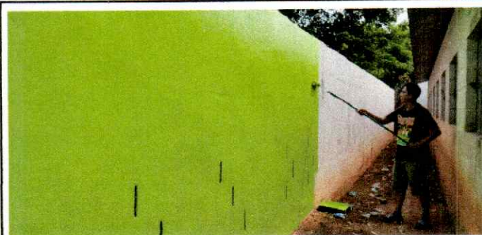
Foto 4: Se verifica la aplicación de pintura en muros exteriores.
