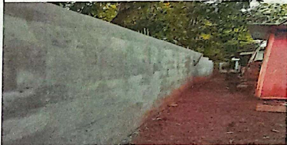
Foto 2: terminación de pared perimetral de concreto
