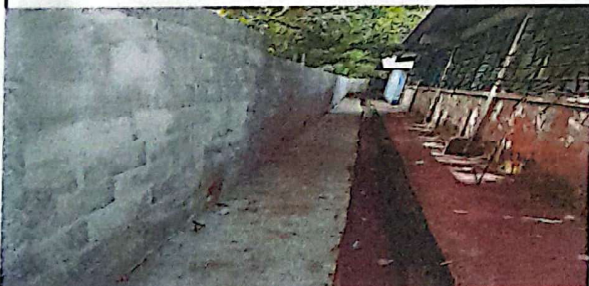
Foto 3: Terminación de pared perimetral de concreto
