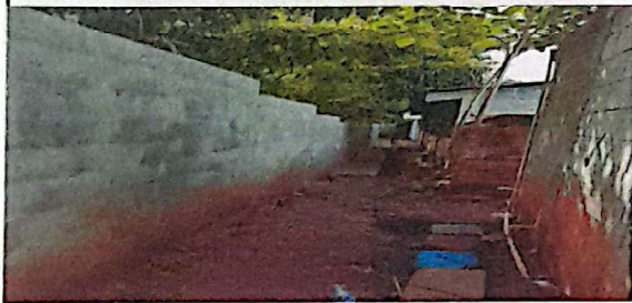
Foto 1: Terminación de pared perimetral de concreto
