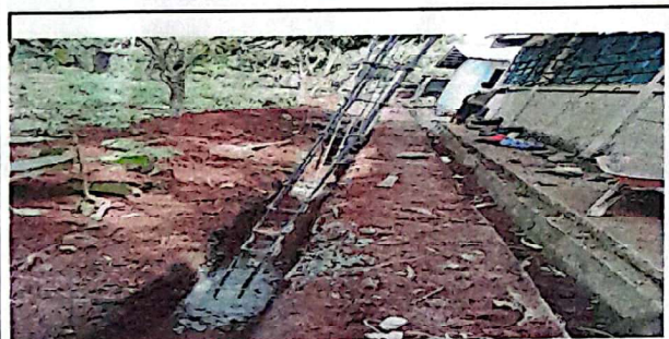
Foto 3 sustitución de lamina perimetral por muro de concreto
