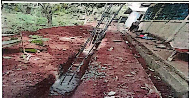
foto 1 Sustrucción de lamina perimetral por muro de concreto
