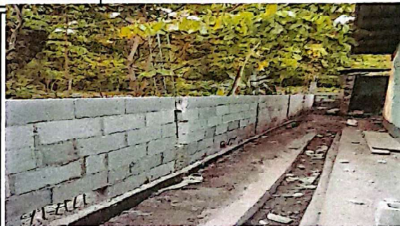
foto 2 sustitución de lamina perimetral por muro de concreto
