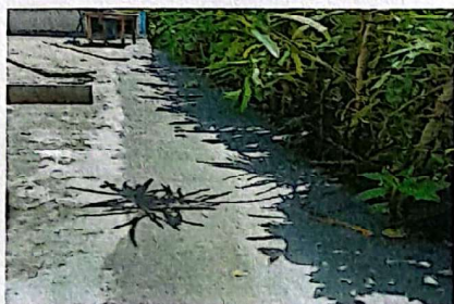
Foto: VISTA MANTENIMIENTO DE CUNETA
