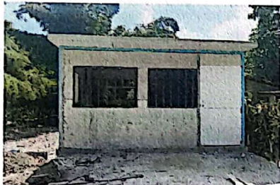
Foto1: VISTA DE REMODELACION DE COCINA 100%
