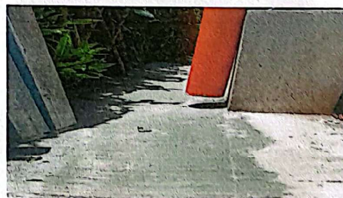
Foto 6: MANTENIMIENTO DE CUNETA
