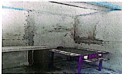
Foto 3: SUSTITUCION DE ESTUFA
