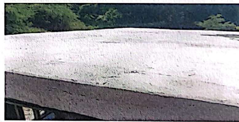
Foto 2: VISTA DE TECHO DE COCINA
