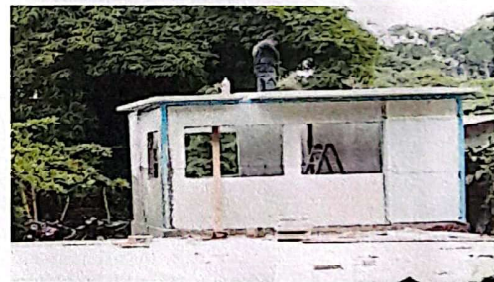
Foto 4: INSTALCION DE PAREDES Y PUERTA DE COGINA
