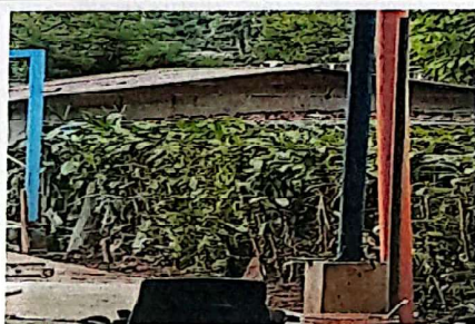
Foto 5: MANTENIMIENTO DE CUNETA
