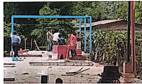
Foto 2: INSTALACIÓN DE PAREDES
