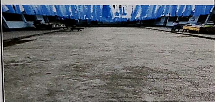
Foto 3: Suministro de piso de torta de concreto T=10, cemento 85 U, 12m3 pldrln, 12m3 Arena de río.
