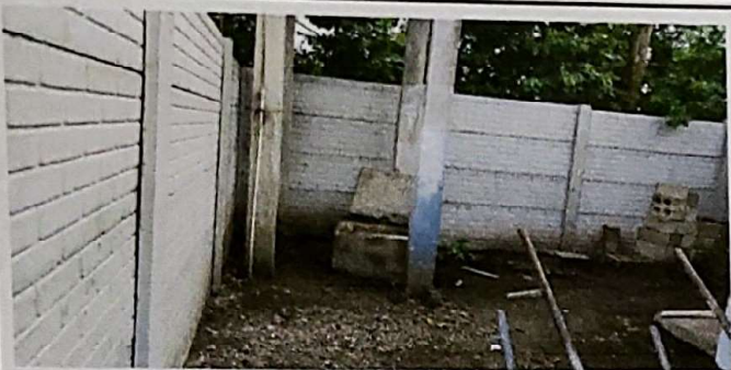
Foto 1: Sustrucción de muro perimetral prefabricado de concreto reforzado H=2.5m
