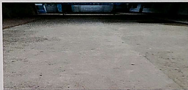
Foto 4: Suministro de piso de torta de concreto T=10, cemento 85 U, 12m3 pldrln, 12m3 Arena de río.
