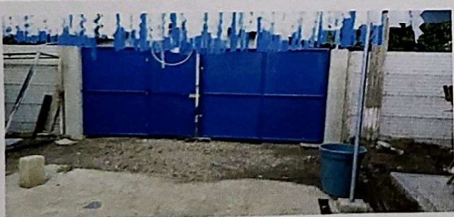
Foto 5: Fabricación de portón metálico 5.00x2.5m doble hoja electromalla reforzada
