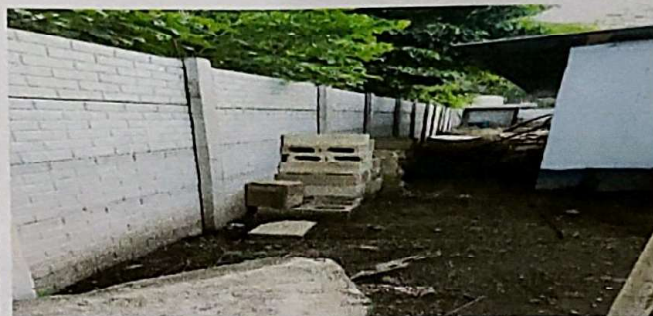
Foto 2: Sustrucción de muro perimetral prefabricado de concreto reforzado H=2.5m
