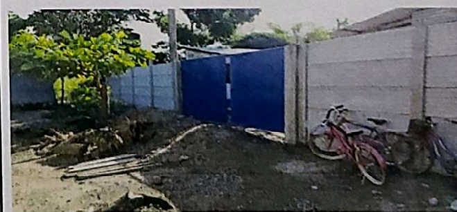
Foto 6: Fabricación de portón metálico 5.00x2.5m doble hoja electromalla reforzada
