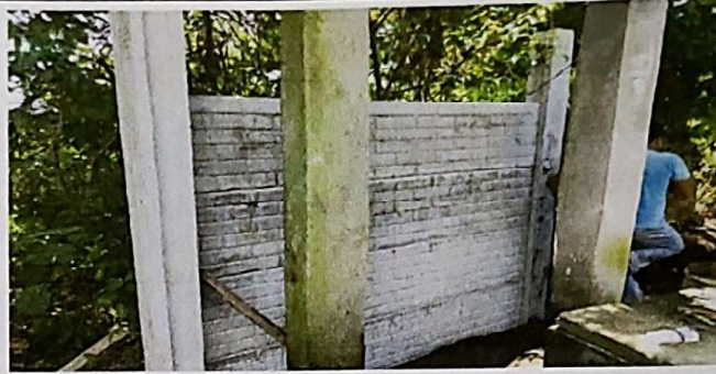
Foto 2: Sustitución de muro perimetral prefabricado de concreto reforzado H=2.5m
