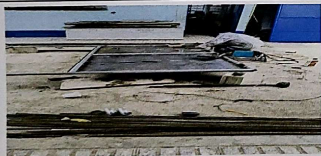
Foto 5: Fabricación de portón metálico 3.00x2.5m doble hoja electromalla reforzada
