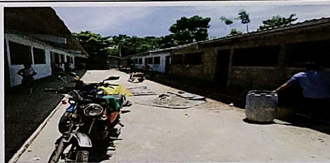
Foto 4: Suministro de piso de torta de concreto T=10, cemento 85 U, 12m3 pldrín, 12m3 Arena de río.
