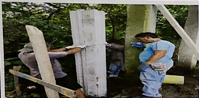
Foto 1: Sustitución de muro perimetral prefabricado de concreto reforzado H=2.5m
