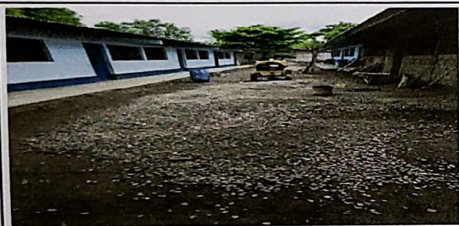
Foto 3: Suministro de piso de torta de concreto T=10, cemento 85 U, 12m3 pldrín, 12m3 Arena de río.
