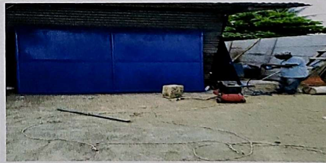
Foto 6: Fabricación de portón metálico 3.00x2.5m doble hoja electromalla reforzada
