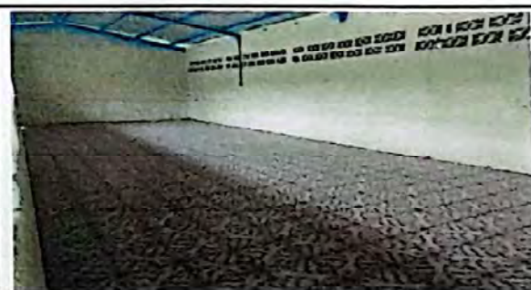
Foto 4: ESTADO INTERIOR DE AULA EN MODULO 1
