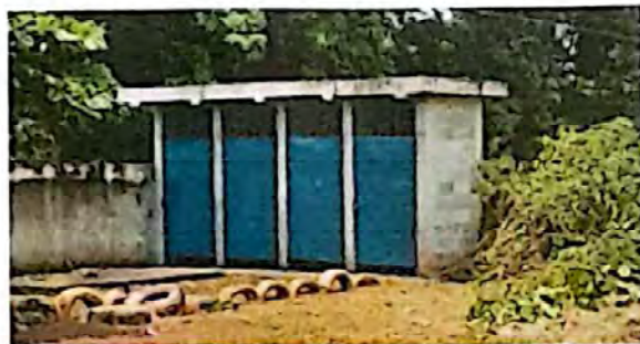
Foto 2: ESTADO FÍSICO DE MÓDULO DE SANITARIOS
