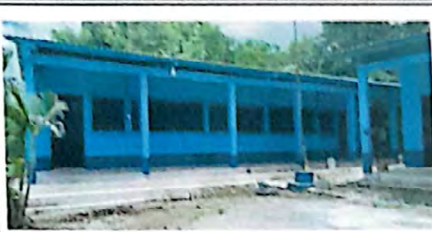
Foto 2: ESTADO EXTERIOR DE MODULO 2
