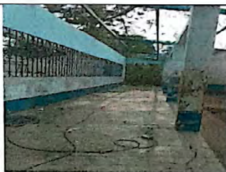
Foto 4: ESTADO INTERIOR DE AULA EN MÓDULO 1
