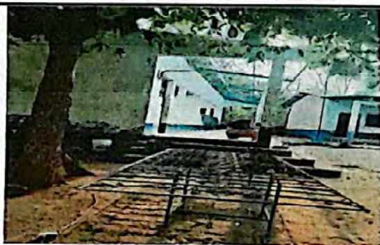
Foto 5: ESTADO DE BALCONES DE MÓDULO 1
