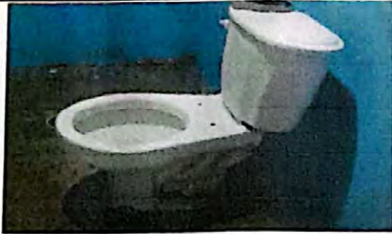
Foto 1: ESTADO ACTUAL DE SANITARIOS
