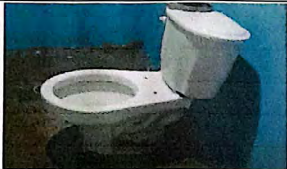
Foto 1: ESTADO ACTUAL DE SANITARIOS
