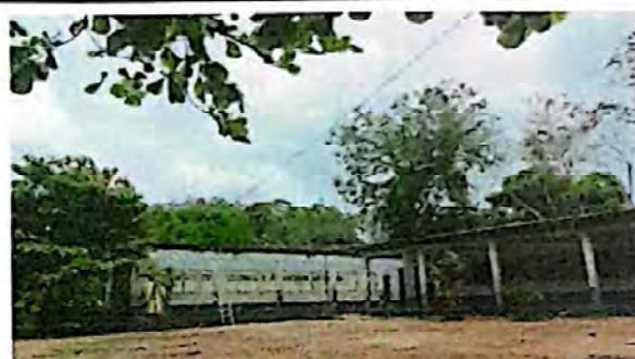
Foto 2: ESTADO EXTERIOR DE MODULO 2
