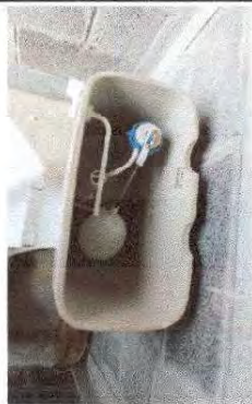
Foto 1: Estado actual de sanitarios.
