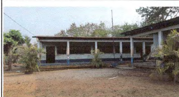
Foto 8: Estado exterior de módulo 2.
