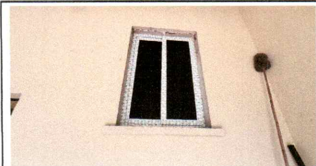
Foto 5: Se puede verificar el avance en la instalación de ventanas.
