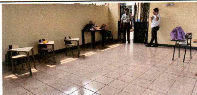
Foto 4: Se ha finalizado la instalación de piso en aula 1.
