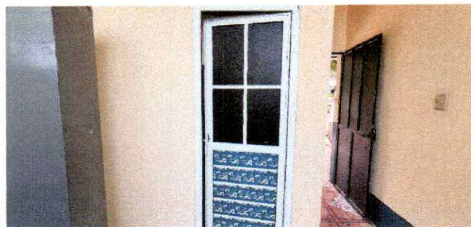
Foto 10: Se puede verificar la instalación de puerta en área de baños.
