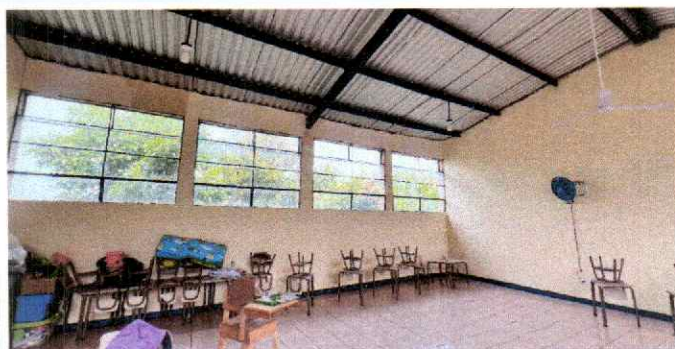
Foto 8: Se puede verificar el remozamiento de vidrios en ventanas, y la instalación de piso en aula 2.
