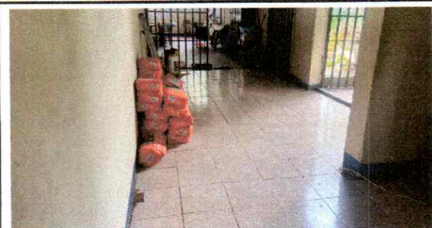
Foto 3: Se ha concluido con la colocación de piso en área de corredor.
