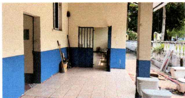
Foto 9: Se puede verificar la instalación de piso en area de corredor de módulo de aulas.
