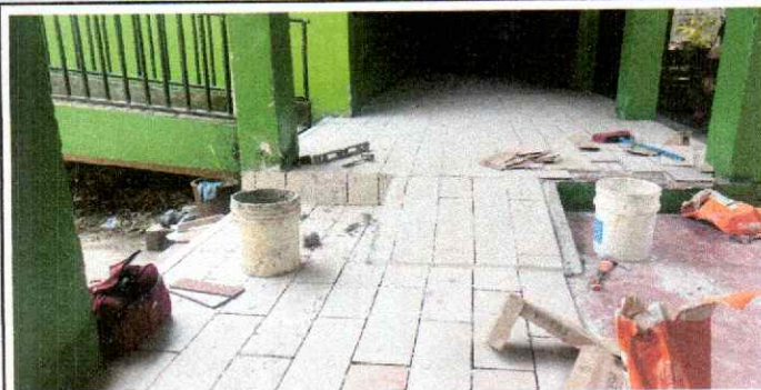
Foto 2: Puede verificarse el avance en la colocación de piso en área de corredor, hace falta realizar la limpieza correspondiente.
