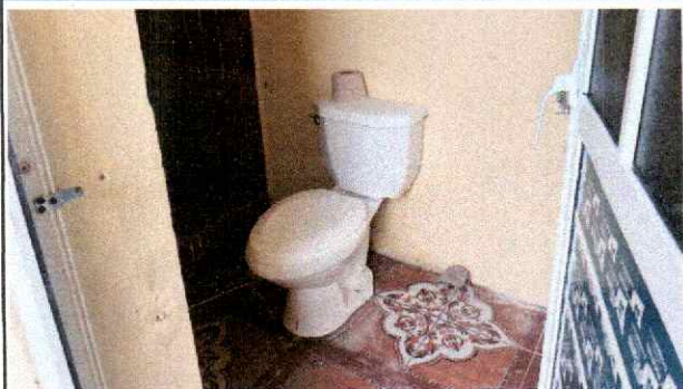
Foto 7: Se puede verificar la instalación de inodoro en módulo de baños 2.
