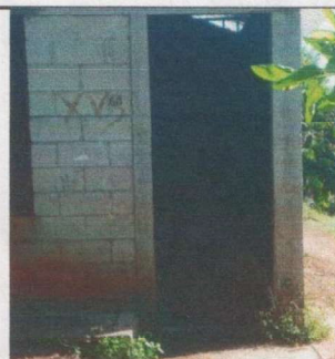
Foto 4: Sustitucion de puerta de metal 2.56 m x
