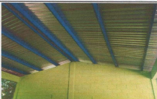
Foto 3: mantenimiento de estructura soporte de metal
