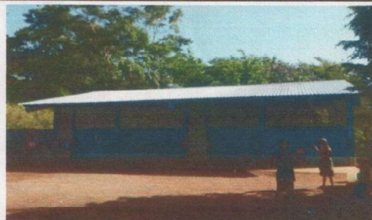
Foto 2: sustrución de lamina modulo 2
