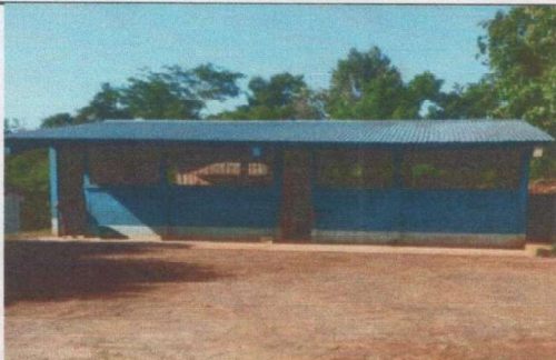
Foto1: Sustrución de lamina modulo 1
