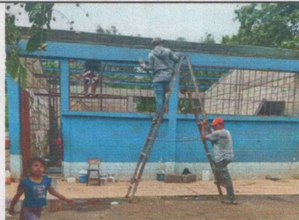
Foto 2: sustitucion de lamina modulo 2
