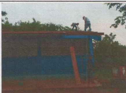
Foto 3: mantenimiento de estructura soporte de metal
