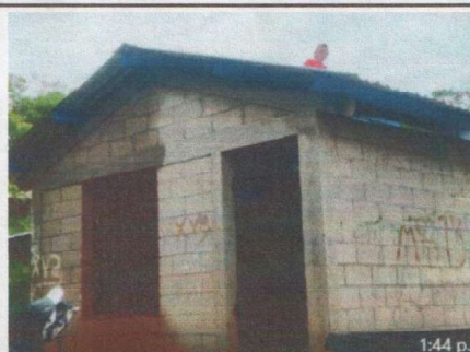
Foto 4: Sustitucion de puerta de metal 2.56 m x
