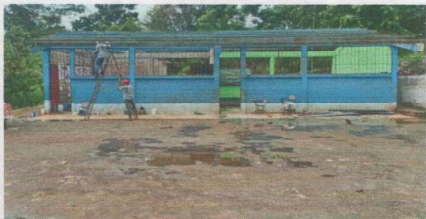
Foto1: Sustitucion de lamina modulo 1
