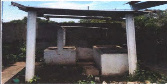
FOTO 1: Suministro y sustitucion de estructura metalica pozo
