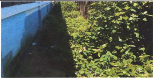
FOTO 9: Suministro y sustitucion de banqueta de concreto
