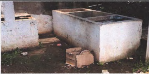
FOTO 5: Suministro y sustitucion de pila de concreto
