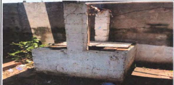
FOTO 4: Suministro y reparacion de brocal de pozo
