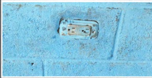
FOTO 8: Suministro e instalacion de sistema electrico
