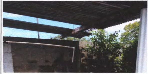
FOTO 2: suministro y sustitucion de lamina troquelada C26 pozo
