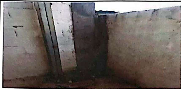
Foto 1: Sustitución de columnas de concreto
