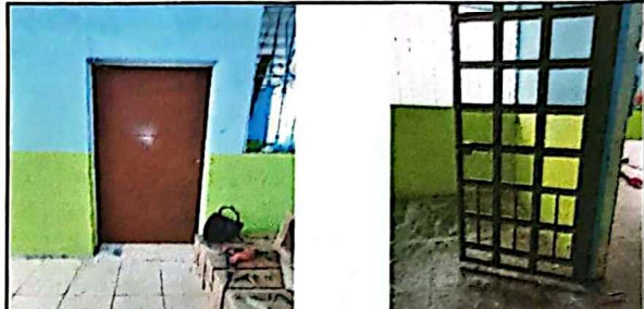
Foto 2: Reparación y mantenimiento de puertas de metal
