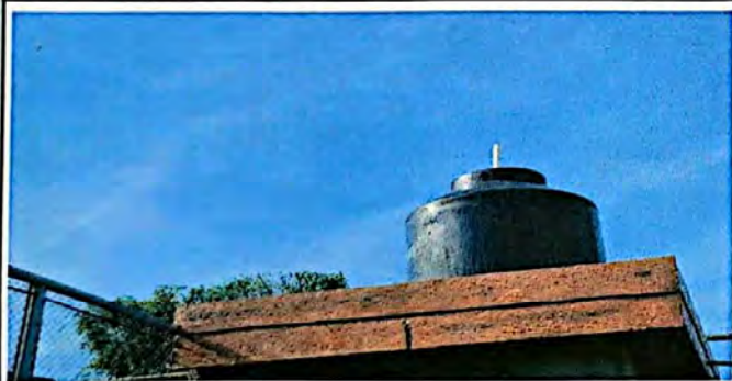
Foto 3: Sustitución de depósito de agua de 1100 litros
