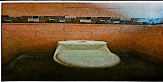
Foto 5: Sustitución de sanitarios y sus accesorios
