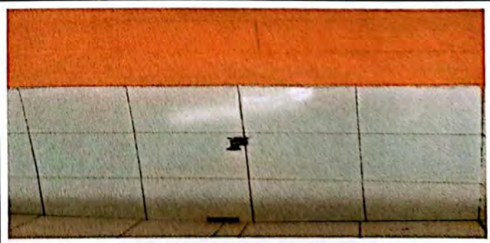
Foto 6: Sustitución de mingitorios
