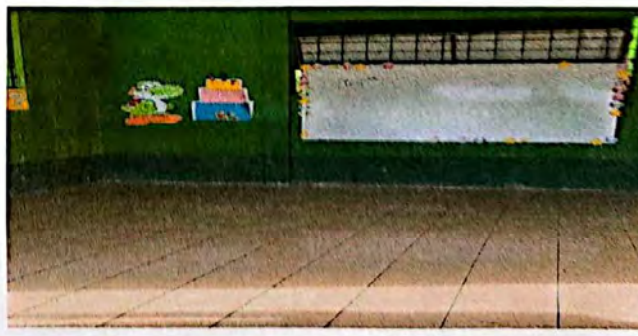
Foto 6: Sustitución de piso de cemento por cerámico
