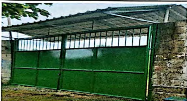
Foto 1: Mantenimiento a portones de metal
