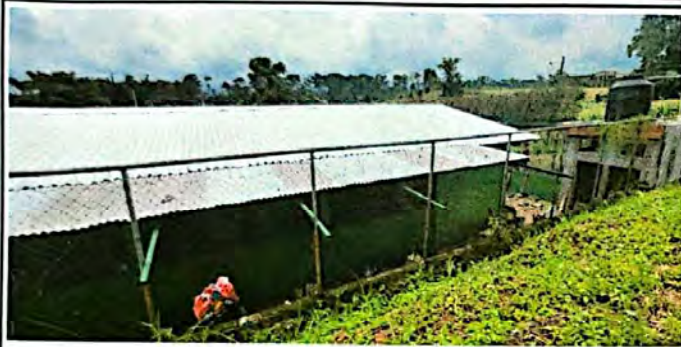
Foto 1: Sustitución de lámina acanalada por lámina troquelada aluzinc calibre 26
