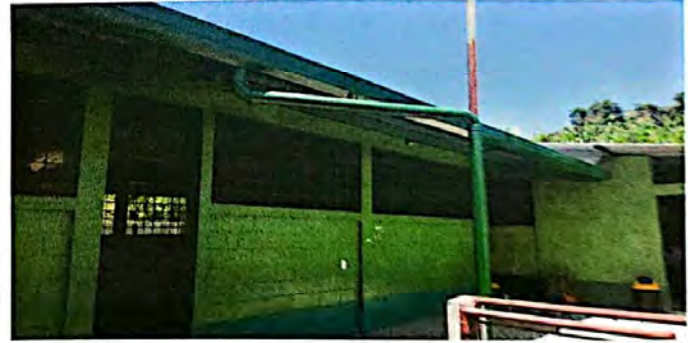
Foto 4: Sustitución de soporte o pescante de metal para canal y bajada de agua pluvial
