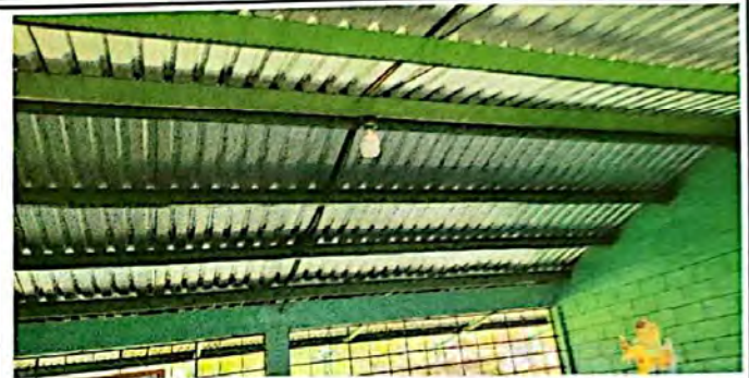
Foto 2: Mantenimiento a estructura de soporte de metal
