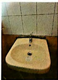
Foto 5: Sustitución de lavamanos
