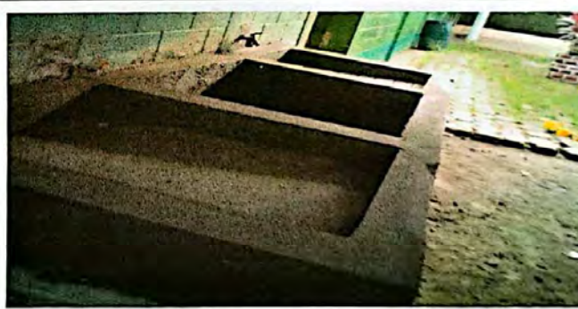
Foto 4: Sustitución de pila de cemento de 2 lavaderos
