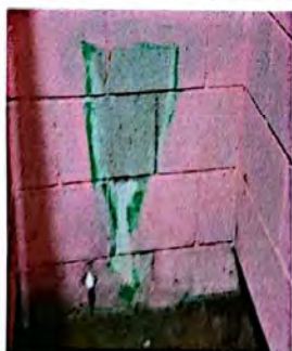
Foto 5: Sustitución de lavamanos
