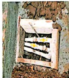
Foto 2: Reparación a red de drenaje y red de agua potable
