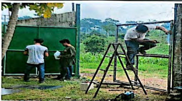
Foto 1: Mantenimiento a portones de metal
