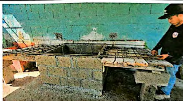
Foto 4: Sustitución de pila de cemento de 2 lavaderos
