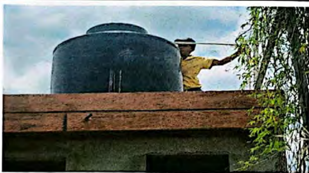
Foto 3: Sustitución de depósito de agua de 1100 litros
