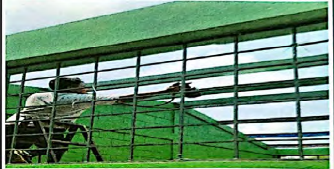
Foto 2: Mantenimiento a estructura de soporte de metal
