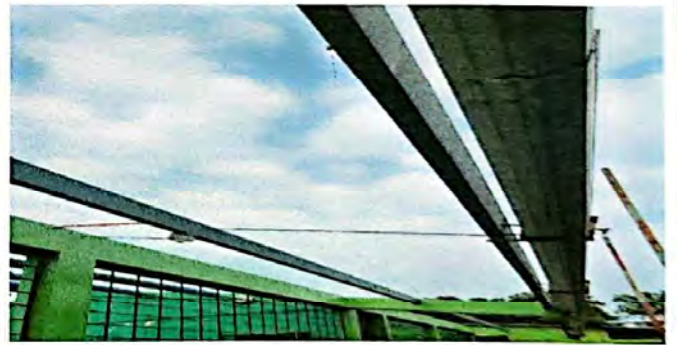
Foto 4: Sustitución de soporte o pescante de metal para canal y bajada de agua pluvial
