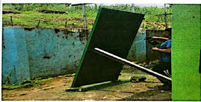
Foto 3: Mantenimiento a estructura, lijado, cambio de tubo, cepillado, sujeciones y aplicación de pintura en puertas de metal y sustitución de chapa en puerta de metal
