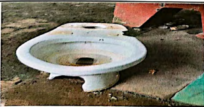
Foto 5: Sustitución de sanitarios y sus accesorios
