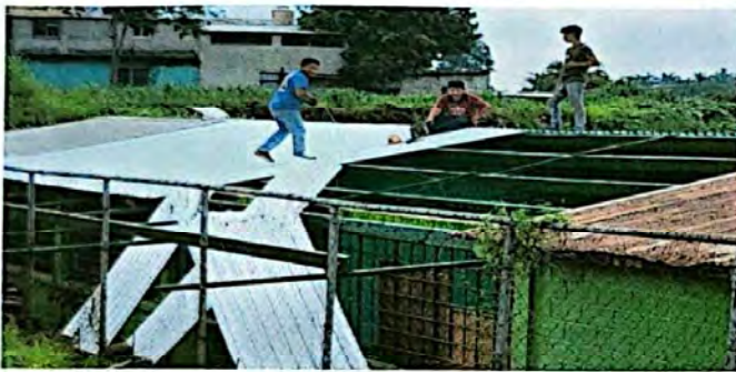
Foto 1: Sustitución de lámina acanalada por lámina troquelada aluzinc calibre 26
