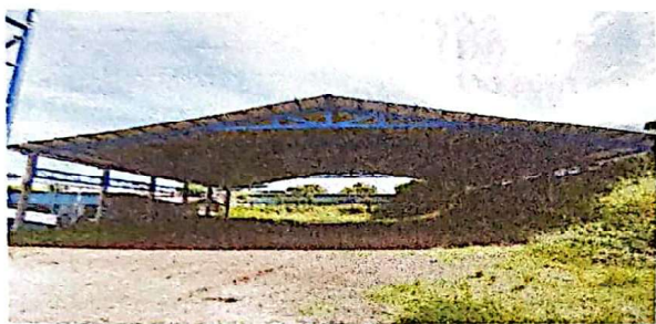
Foto 3: INSTALACIÓN CUBIERTA DE LÁMINA TROQUELADA
