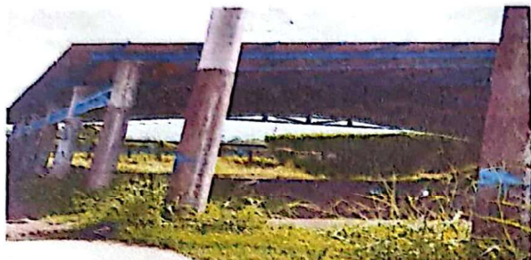
Foto 1: INSTALACIÓN DE ESTRUCTURA METÁLICA
