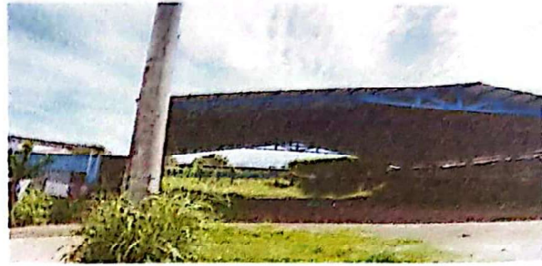
Foto 2: INSTALACIÓN DE ESTRUCTURA METÁLICA
