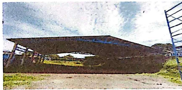
Foto 4: INSTALACIÓN CUBIERTA DE LÁMINA TROQUELADA
