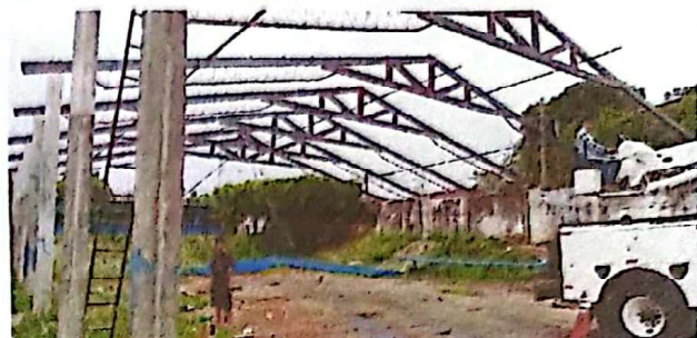
Foto 2: INTALACIÓN DE ESTRUCTURA METÁLICA
