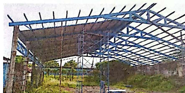
Foto 4: INSTALACIÓN CUBIERTA DE LÁMINA TROQUELADA
