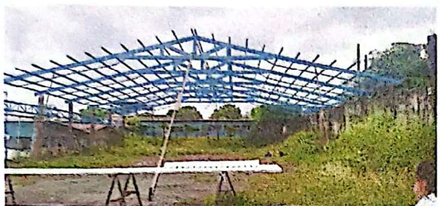
Foto 3: INSTALACIÓN CUBIERTA DE LÁMINA TROQUELADA
