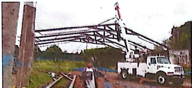
Foto 1: INSTALACIÓN DE ESTRUCTURA METÁLICA
