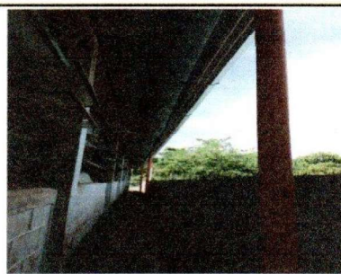
Foto 4: SUMINISTRO E INSTALACIÓN DE CANALES PARA BAJADA DE AGUA PLUVIAL
