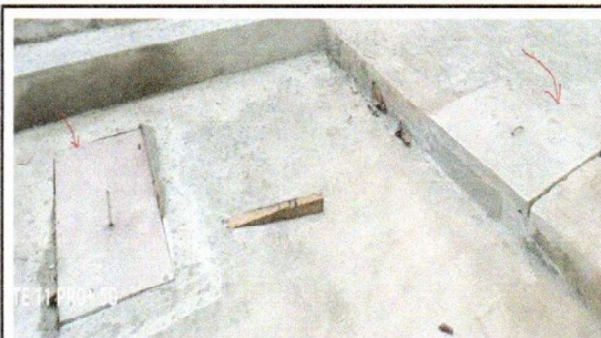
Foto 3: SUMINISTRO E INSTALACION DE BIODIGESTOR ROTOPLAS y FOSA SEPTICA
