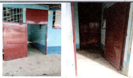
Foto 2: SUSTITUCION E INSTALACION DE 15 PUERTAS DE METAL EN AULAS
