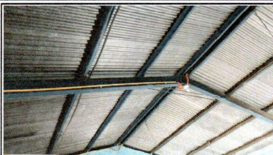
Foto 1: REPARACION DEL SISTEMA ELECTRICO EN AULAS
