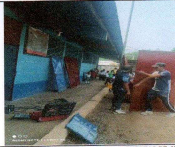
Foto 2: SUSTITUCION E INSTALACION DE 15 PUERTAS DE METAL EN AULAS
