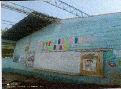
Foto 1: REPARACION DE SISTEMA ELECTRICO EN AULAS
