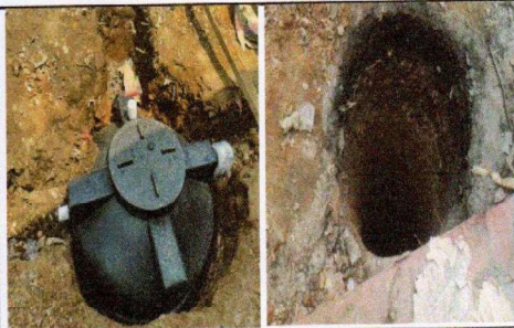
Foto 3: SUMINISTRO E INSTALACION DE BIODIGESTOR ROTOPLAS COMO FOSA SEPTICA
