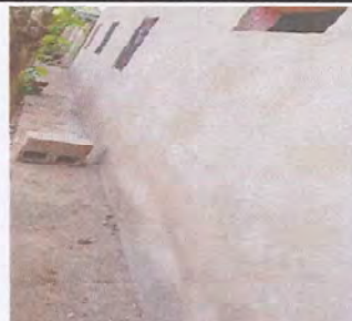
Foto 8: REPARACION DE BANQUETA DE CONCRETO
