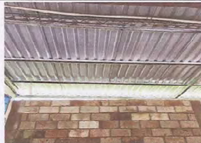
Foto 6: SUSTITUCIÓN DE LAMINA POR LAMINA TROQUELADA C26
