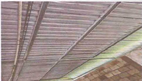
Foto 5: SUSTITUCIÓN DE ESTRUCTURA DE METAL DE SOPORTE DE TECHO
