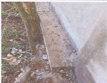
Foto 7: REPARACION DE BANQUETA DE CONCRETO
