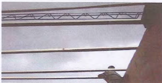
Foto 5: SUSTITUCIÓN DE ESTRUCTURA DE METAL DE SOPOTE DE TECHO
