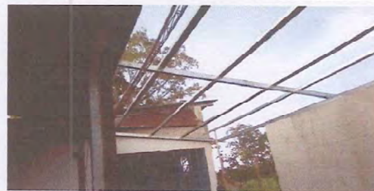
Foto 6: SUSTITUCIÓN DE LAMINA POR LAMINA TROQUELADA C26
