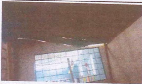
Foto 5: SUSTITUCIÓN DE LAMINA POR LAMINA TROQUELADA CALIBRE 26 EN 1 AULA
