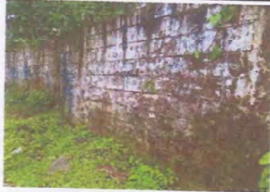
Foto 1: SUMINISTRO Y REPARACIÓN DE MURO PERIMETRAL
