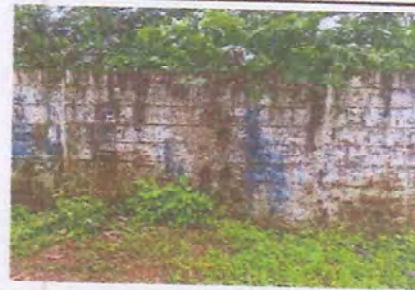
Foto 2: SUMINISTRO Y REPARACIÓN DE MURO PERIMETRAL
