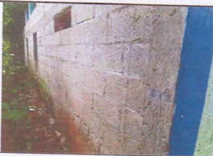
Foto 3: REPARACION DE PARED EXTERIOR EN 1 AULA
