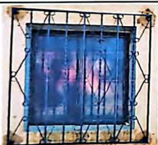
Foto 3: Instalación de Ventanas de Metal
