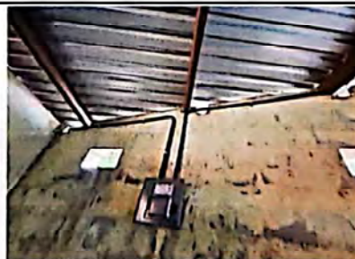
Foto 6: Sustitución de Tablero de filpones de 8 circuitos
