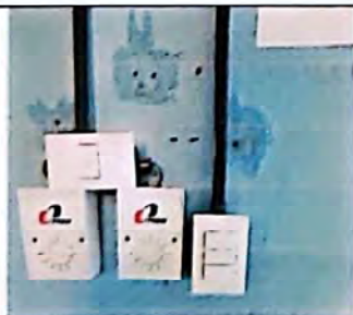
Foto 5: Sustitución de Tomacorrientes Dobles
