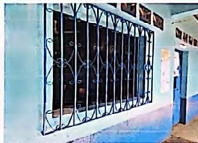
Foto 2: Sustitución de balcones de metal
