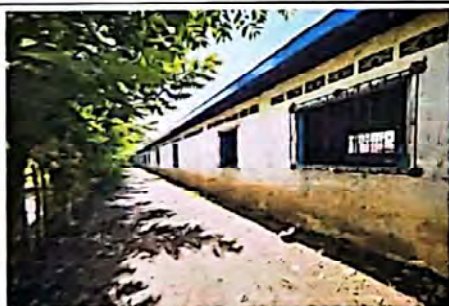
Foto 3: Instalación de Ventanas de Metal
