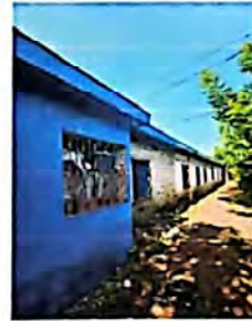
Foto 8: Mantenimiento de Balcones
