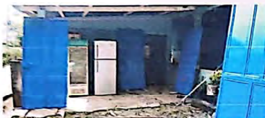
Foto 1: Sustrución de puertas nuevas de metal con Chapa Yale
