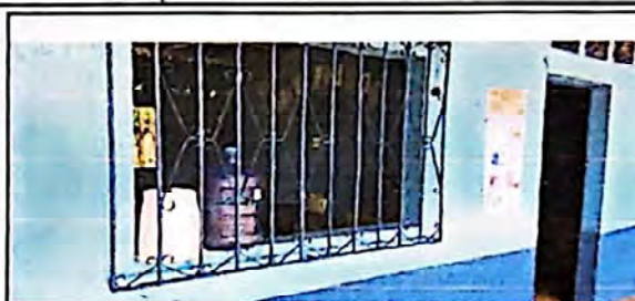
Sustitución de balcones de metal
