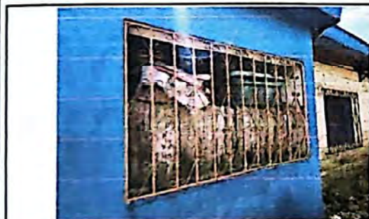
Instalación de Ventanas de metal
