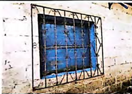
Mantenimiento de balcones de metal.
