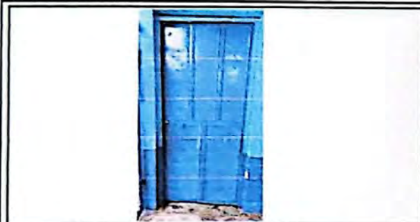
Sustitución de puertas nuevas de metal con chapa Yale
