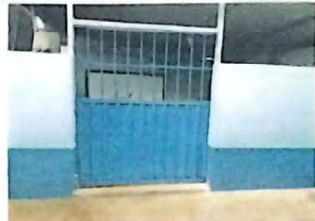
Foto 4: Suministro y sustitución de puerta de metal modulo 2
