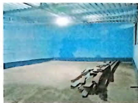
Foto 6: Suministro y sustitución de lamina C 26 modulo 2
