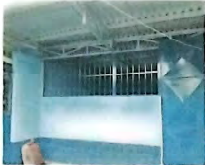
Foto 1: Suministro y sustitución de estructura metálica aula modulo 2
