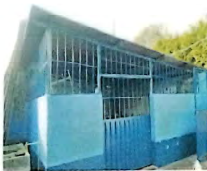
Foto 5: Suministro y sustitución de muro de aula modulo 2
