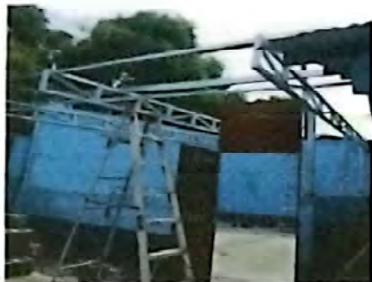
Foto 1: Suministro y sustitución de estructura metálica aula modulo 2
