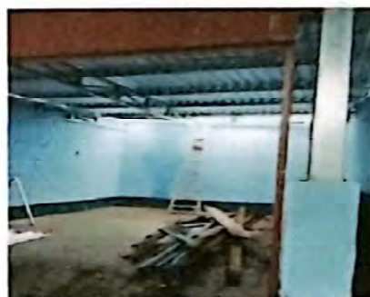
Foto 6: Suministro y sustitución de lamina C 26 modulo 2
