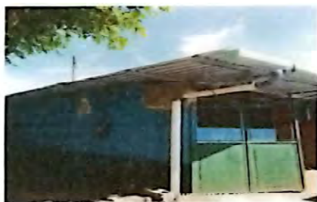
Foto 3: Suministro y sustitución de porton de metal
