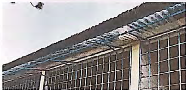
Foto 1: suministro e instalación de 6 láminas traslucidas de 10 pies en estructura de metal en ventanas.
