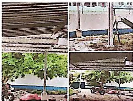
Foto 3: suministro e instalación de estructura soporte por metal en módulo 5
