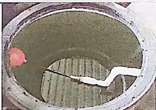
Foto 9: mantenimiento de Reparación de sistema de agua potable con cisterna y cambios de accesorios
