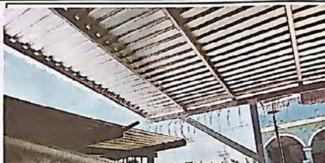
Foto 2: suministro e instalación de lámina troquelada calibre 26 en módulo 5
