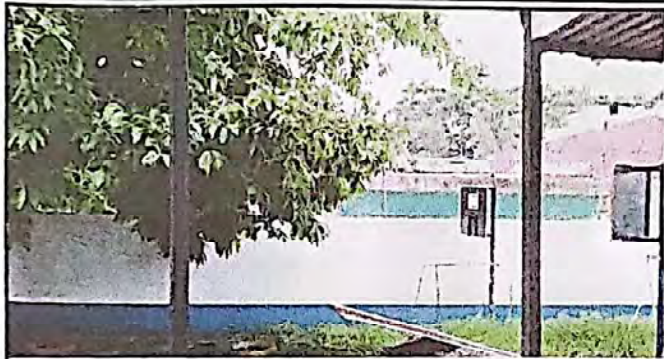
Foto 7: suministro y aplicación de pintura exterior en muro perimetral area interior de latex blanco y azul
