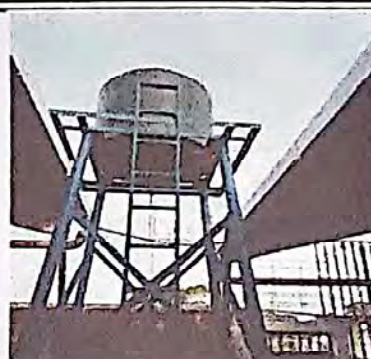
Foto 8: sustitucion de estructura de soporte por metal para colocación de rotoplast.
