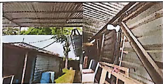
Foto 5: mantenimiento de reparación de sistema eléctrico cableado eléctrico calibre 12
