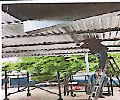
Foto 5: mantenimiento de reparación de sistema eléctrico cableado eléctrico calibre 12
