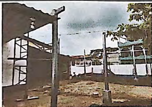
Foto 3: suministro e instalación de estructura soporte por metal en modulo 5
