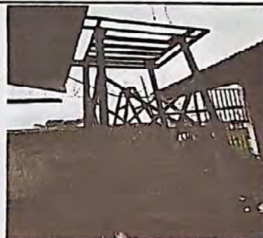
Foto 8: sustitución de estructura de soporte por metal para colocacion de rotoplast
