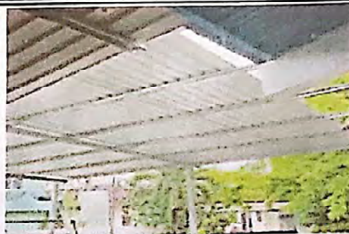
Foto 2: suministro e instalación de lamina troquelada calibre 26 en modulo 5
