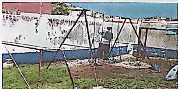
Foto 7: suministro y aplicación de pintura exterior en muro perimetral area interior de latex blanco y azul
