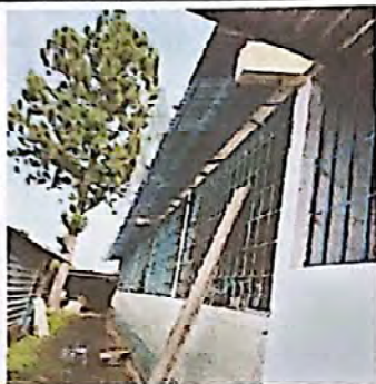
Foto 1: suministro e instalación de 6 laminas traslucidas de 10 pies en estructura de metal en ventanas
