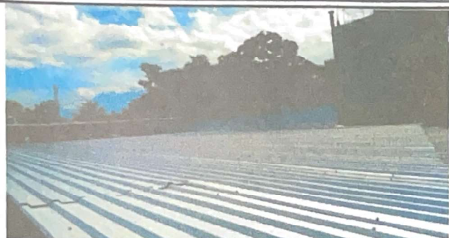
Foto 1: FINALIZACIÓN INSTALACIÓN Y SOLDADURA DE ESTRUCTURA METÁLICA PARA TECHADO DE PATIO
