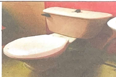
Foto 4: FINALIZACIÓN DE CAMBIO DE SANITARIOS COMPLETOS DE CERÁMICO
