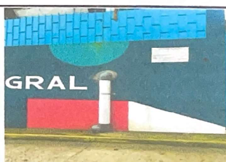
Foto 6: FINALIZACIÓN CON SELLO Y REPELLO CON CEMENTO EN ÁREA DE SALIDA DE DRENAJE PLUVIAL
