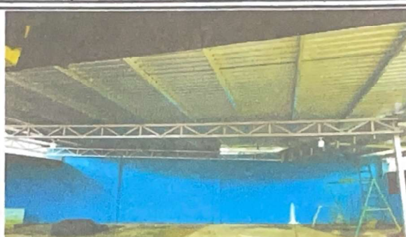
Foto 2: FINALIZACIÓN DE INSTALACIÓN DE LÁMINA TROQUELADA CALIBRE 26 EXACTO
