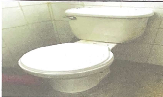
Foto 3: FINALIZACIÓN DE CAMBIO DE SANITARIOS COMPLETOS DE CERÁMICO
