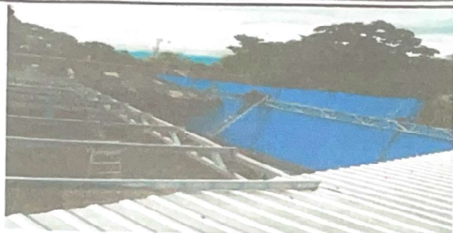
Foto 1: INSTALACIÓN Y SOLDADURA DE ESTRUCTURA METÁLICA PARA TECHADO DE PATIO
