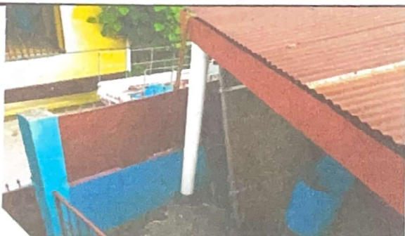
Foto 5: INSTALACIÓN DE CANALETAS PARA EVACUACIÓN DEL DRENAJE PLUVIAL
