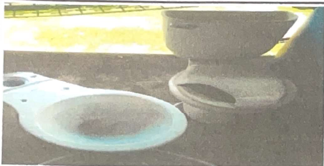
Foto 3: CAMBIO DE SANITARIOS COMPLETOS DE CERÁMICO
