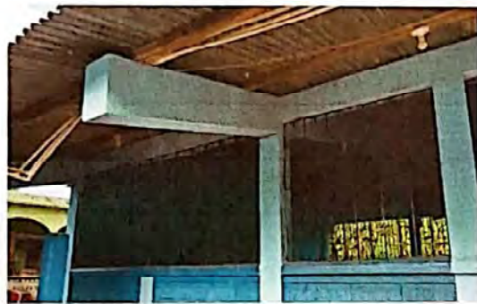
Foto 3: SUMINISTRO E INSTALACION DE HIERRO EN VENTANA
