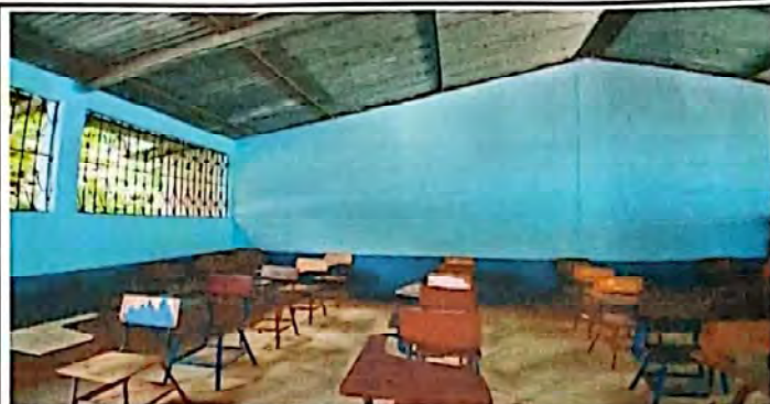
Foto 2: SUMINISTRO DE PINTURA Y KIT PARA INTERIOR
