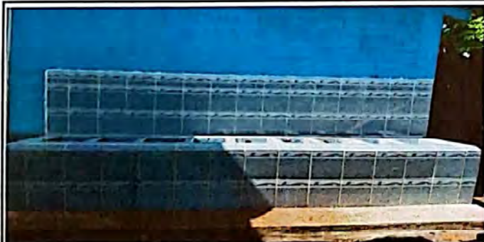
Foto 5: SUMINISTRO E INSTALACION DE PILA CON AZULEJO
