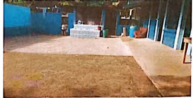
Foto 2: SUMINISTRO E INSTALACION DE PISO DE CONCRETO
