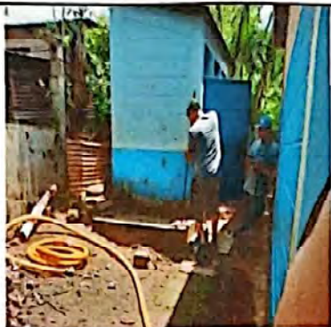
Foto 1: FINALIZACION DE LIMPIEZA DE FOSA
