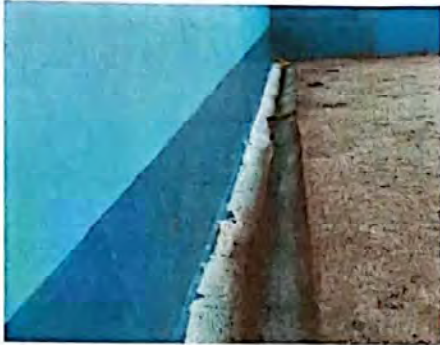
Foto 1: SUMINISTRO E INSTALACION DE CUNETA DE CONCRETO .
