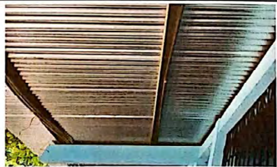
Foto 6: SUSTITUCION E INSTALACION DE LAMINA TROQUELEADA
