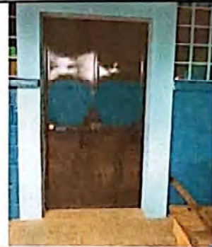
Foto 4: SUMINISTRO E INSTALACION DE PUERTA DE METAL EN AULA 1
