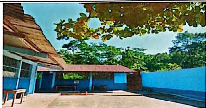
Foto 3: SUMINISTRO DE PINTURA Y KIT PARA EXTERIOR
