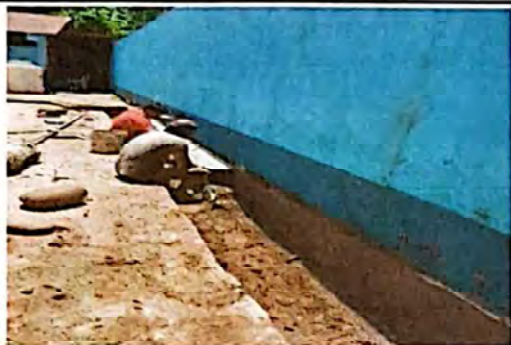
Foto 1: SUMINISTRO E INSTALACION DE CUNETA DE CONCRETO , TAPA DE CONCRETO
