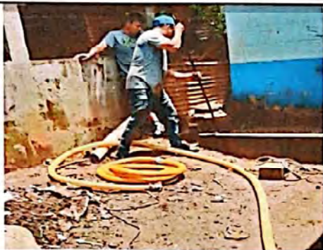
Foto 1: INICIO DE LIMPIEZA DE FOSA
