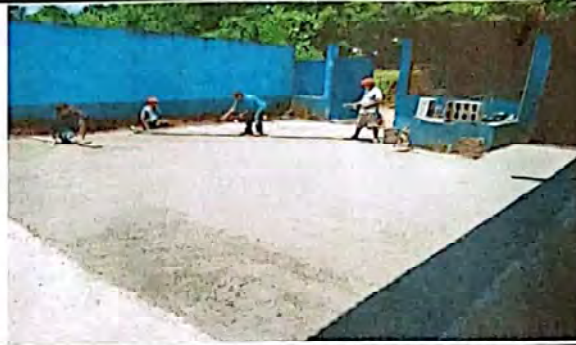
Foto 2: SUMINISTRO E INSTALACION DE PISO DE CONCRETO
