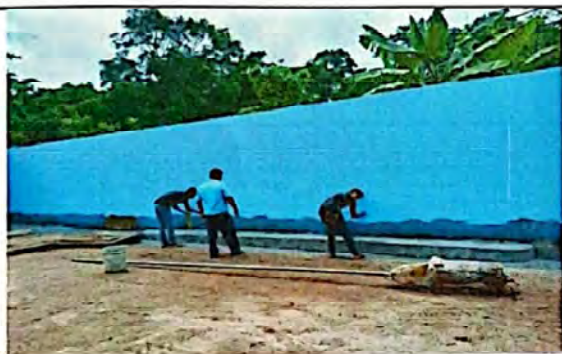
Foto 3: SUMINISTRO DE PINTURA Y KIT PARA EXTERIOR
