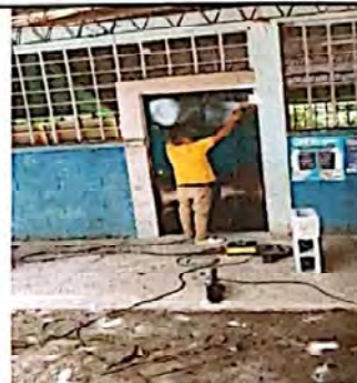
Foto 4: SUMINISTRO E INSTALACION DE PUERTA DE METAL EN AULA 1
