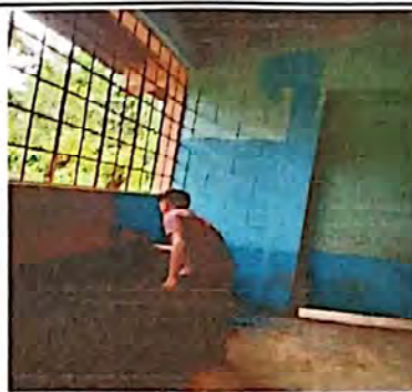
Foto 2: SUMINISTRO DE PINTURA Y KIT PARA INTERIOR
