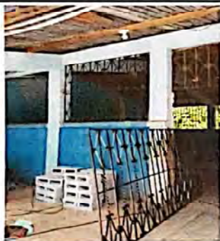
Foto 3: SUMINISTRO E INSTALACION DE HIERRO EN VENTANA
