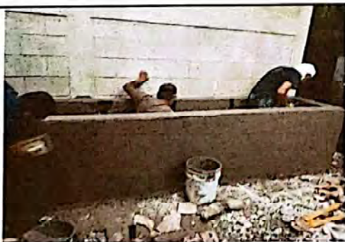
Foto 5: SUMINISTRO E INSTALACION DE PILA CON AZULEJO
