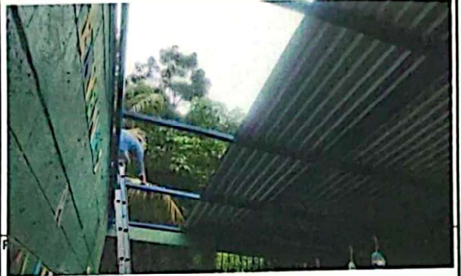
CAMBIO DE LAMINA TROQUELADA ALUZINC CALIBRE 26
