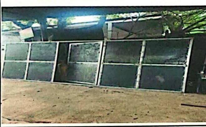
SUSTITUCION DE PORTON DE METAL 4X2
