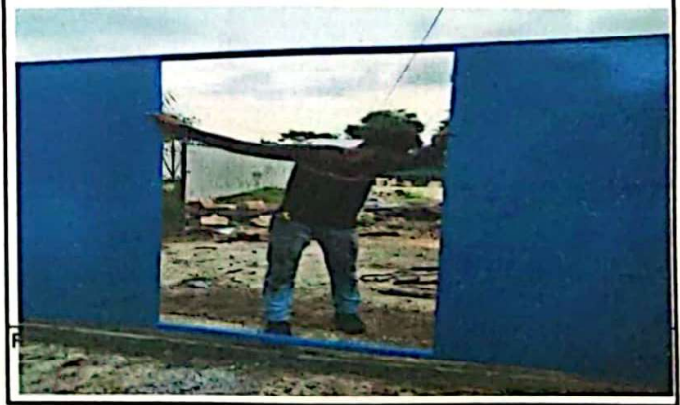
SUSTITUCION DE PORTON DE METAL 4X2
