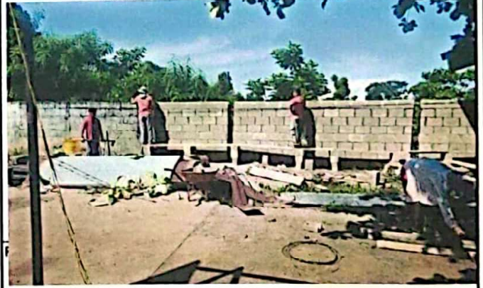
REPARACIÓN Y REPELLO DE MURO PERIMETRAL
