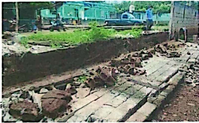
REPARACIÓN Y REPELLO DE MURO PERIMETRAL
