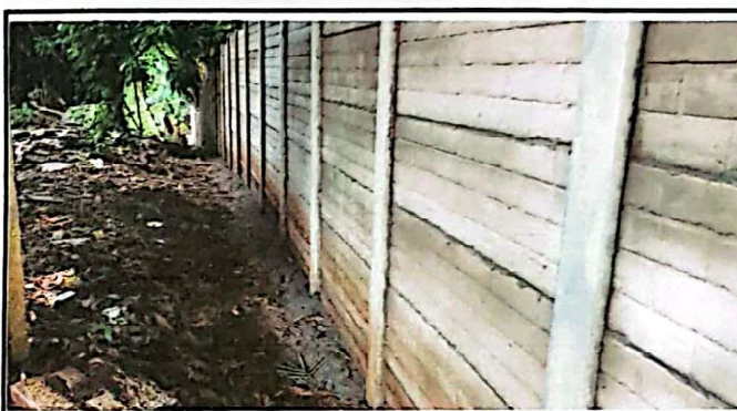
Instalación de Muro Perimetral con material prefabricado de concreto reforzado H=2.50M, e= 5cm. C1 15x15 cm
