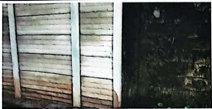
Instalación de Muro Perimetral con material prefabricado de concreto reforzado H=2.50M, e= 5cm. C1 15x15 cm
